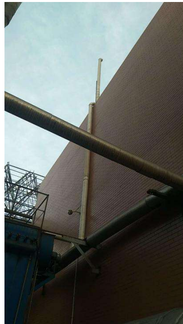
图 3-2 混料排气筒
