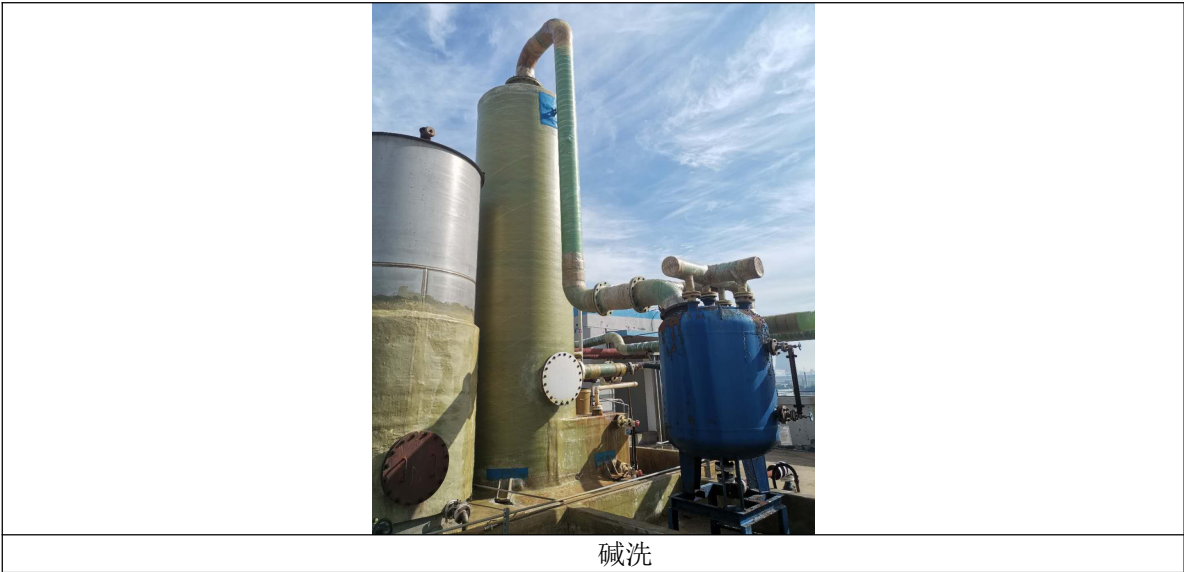
图 2.4-4 无机碘化物生产装置及贵金属催化剂生产装置废气处理设施 (4) 污水处理站废气经“碱喷淋+活性炭”处理后由 1 根 15 米高排气筒。
