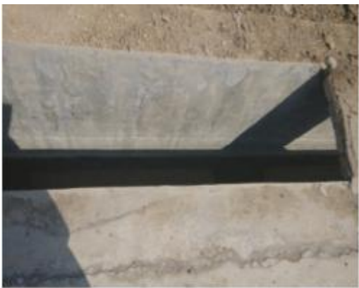
厂内雨水明沟
