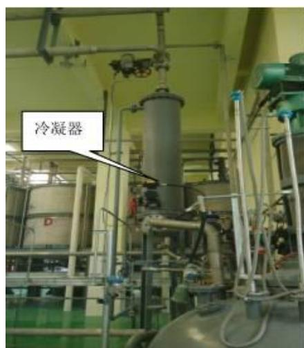
工艺废气冷凝器
